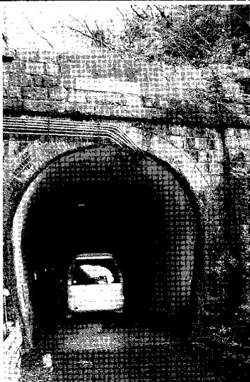
▲敦賀側の入口。クルマ一台通れるだけの幅員しかない。両側の入口には待ち時間を表示した信号がついている。
