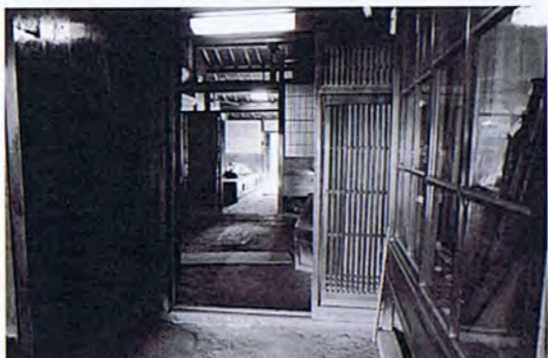
▲江戸時代前期築の鉄砲鍛冶屋敷「井上関右衛門家住宅」。入口から奥まで土間が通り抜けている
