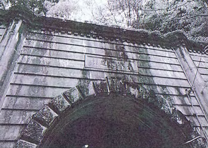
▲彫りの深いアーチ環やデンティル（谷坂隧道／側坑口）
