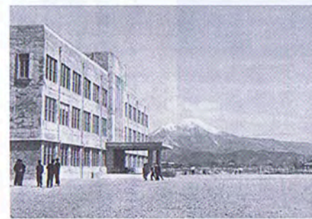
▲完成間近の市庁舎。外装がまだの時期。東に伊吹山が望める
